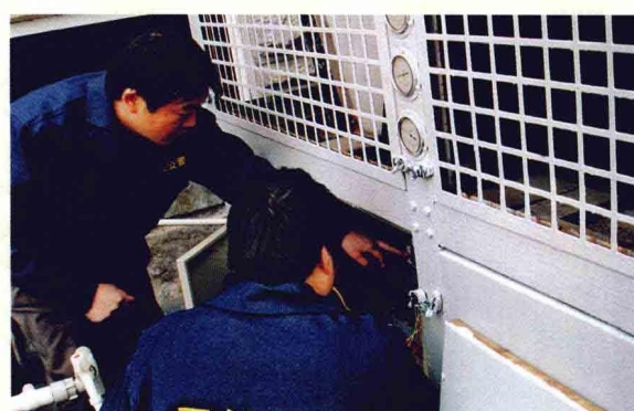
物管人员检修中央空调
