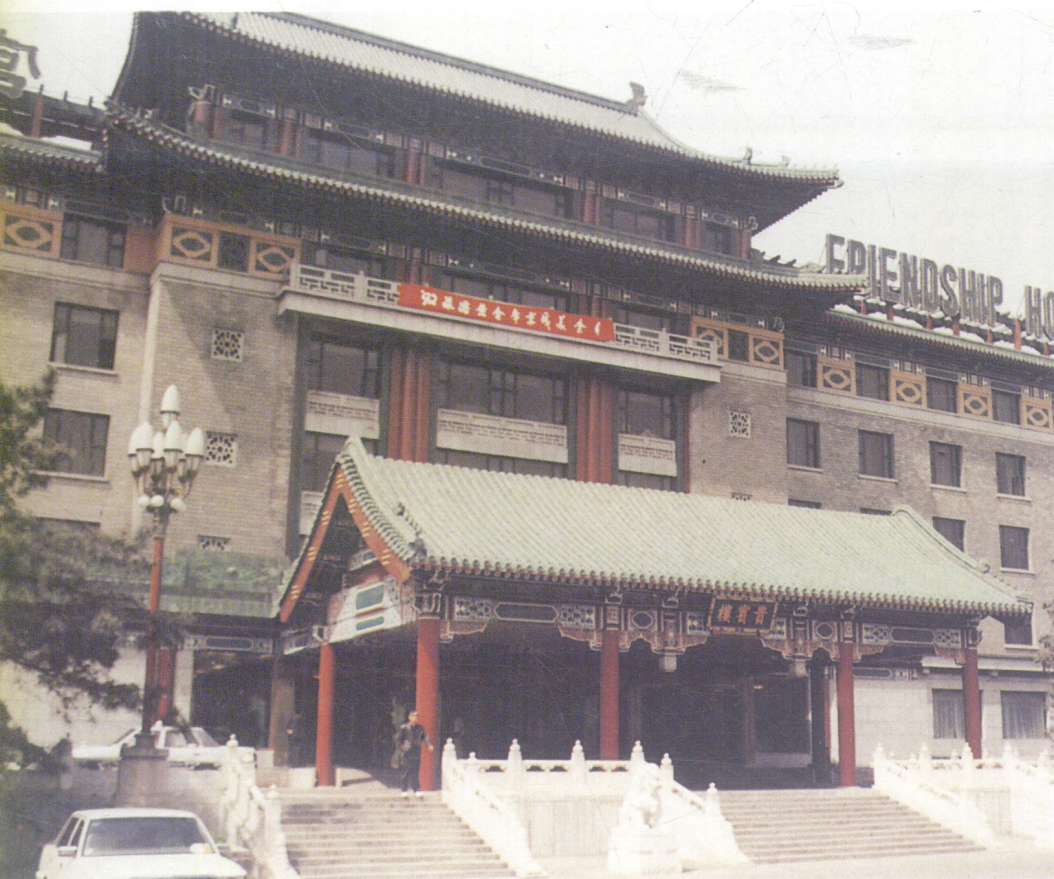
11 新建的友谊宾馆主楼入口，碧瓦、红柱、白玉石栏，雕梁画栋，很有些皇家气派，与原大楼风格十分谐调
