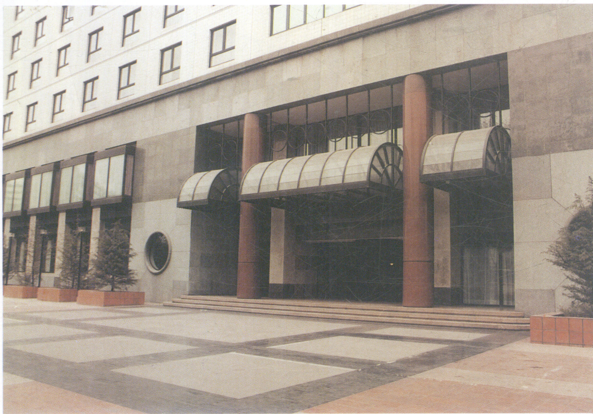
17 悬挂的玻璃雨篷，巧妙地结合艺术处理的吊杆结构，构成大厦又一艺术装饰重点。白、黑、灰、红的花岗岩拼贴组合与方圆曲直的造型搭配，丰富了大门的环境气氛
