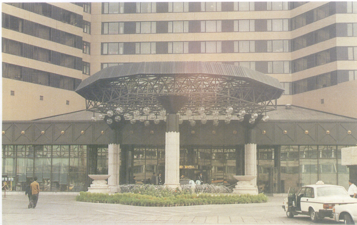
12 昆仑饭店入口。托起的网架上覆多边形采光雨篷，花岗岩立柱
