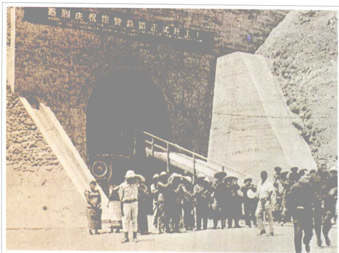
1.1 中国援建坦赞铁路的技术人员抵达坦桑尼亚。图为坦赞铁路开工仪式。
