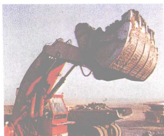
基建工程兵战士熟练地操纵着挖掘机剥离岩石，为多采煤作准备。
