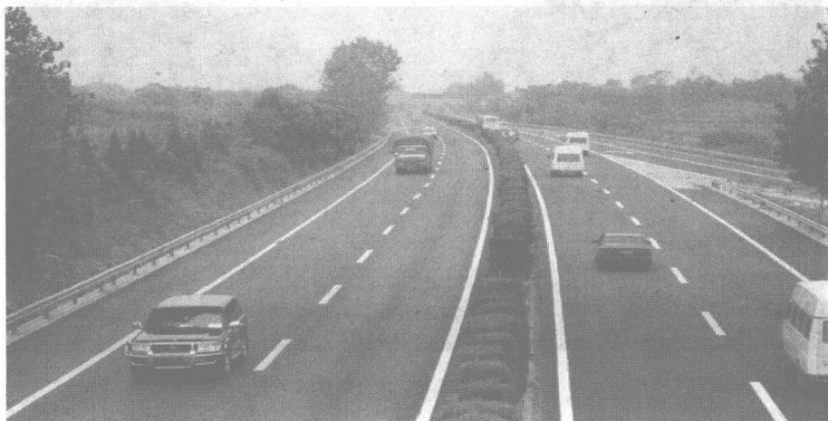
图 1-3 四车道高速公路实例
