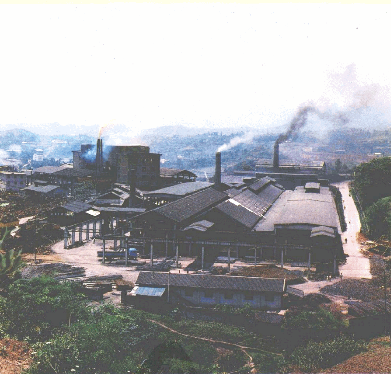
主厂房区现貌
