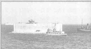
► 组建“桑葚”人工港口的两块混凝土障碍物。
