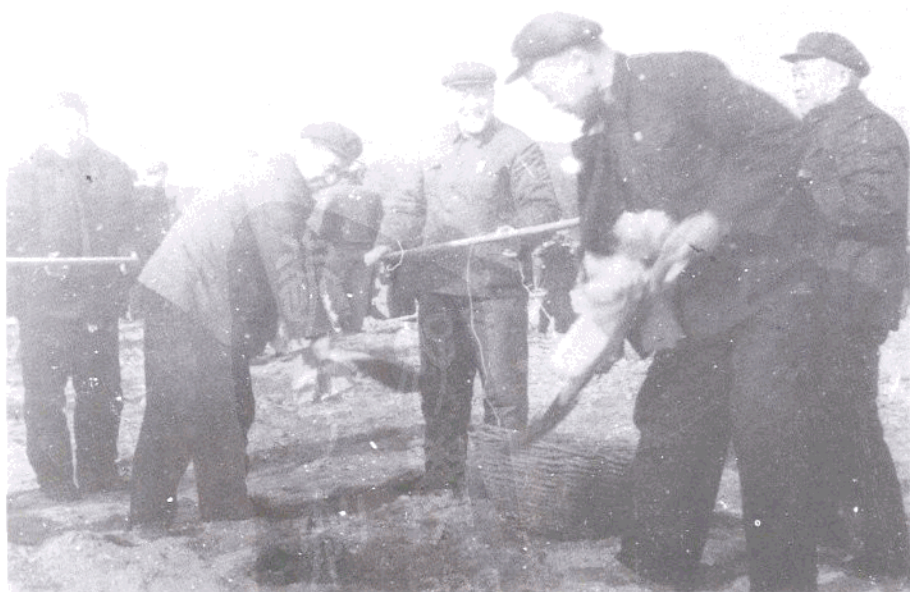
朱川、吴戈等省、市领 导为抚顺小梁河铁矿 破土奠基
