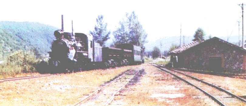
50年代初建设的树基沟坑口至北三家专用窄轨铁路及小型机车
