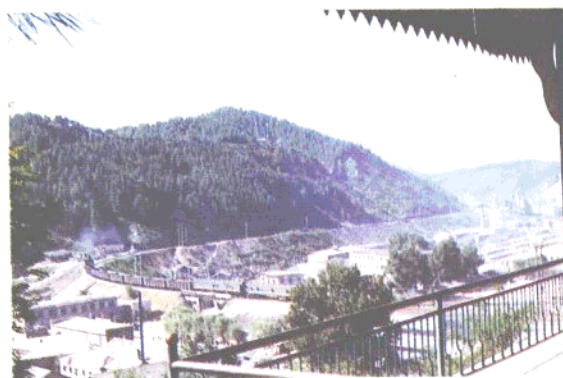
60年代初建设的红透山坑口至登石标准轨 矿山铁路专用线
