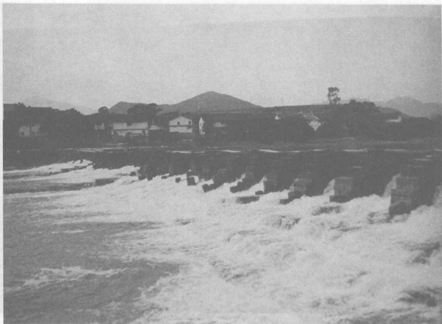
图 25 莆田县宋代木兰陂水利枢纽工程全景
