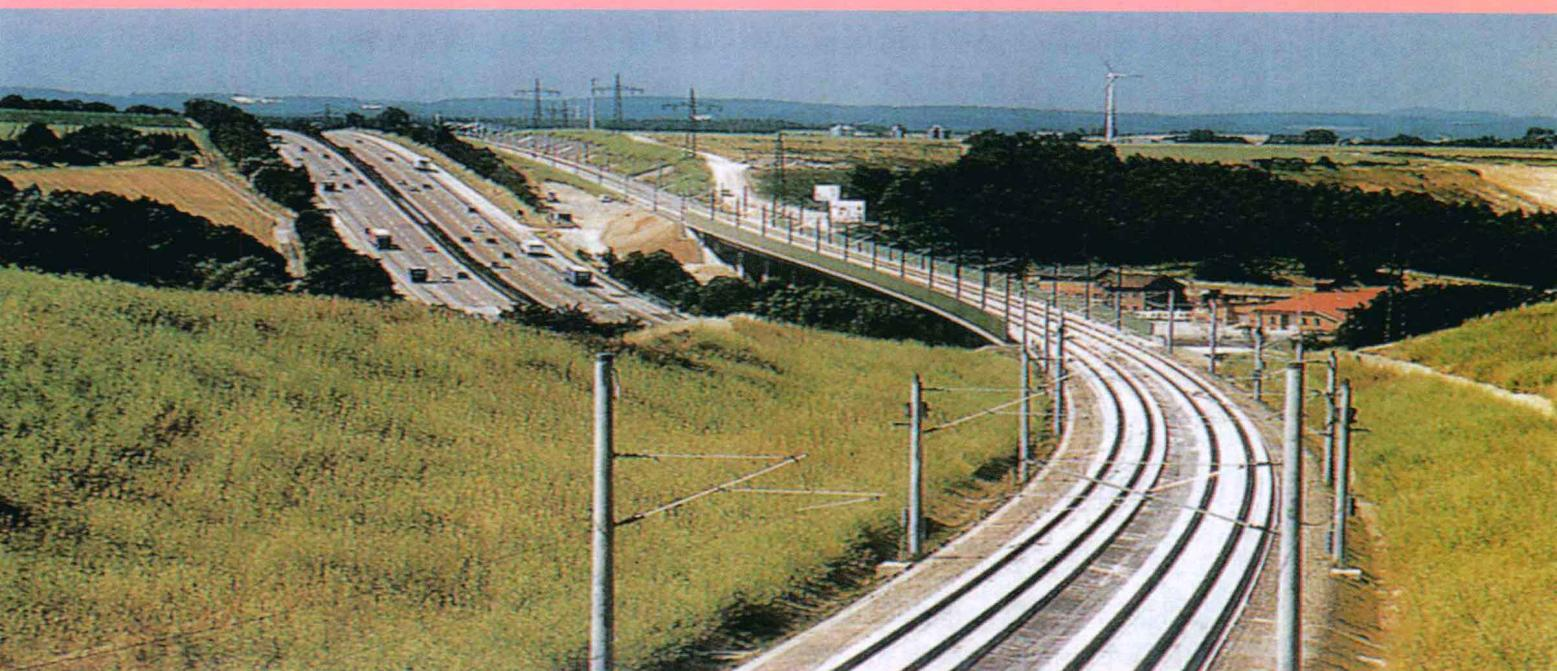
根据我国《中长期铁路网规划》，到 2020 年我国铁路将建成“四纵四横”快速客运通道及三个区域城际快速客运系统。高速度、高密度、长距离跨线运输是我国客运专线主要运营特点。为满足行车安全、乘车舒适和准点行车的要求，铁路线路必须具有结构连续、平顺、稳定、耐久和少维修的性能。无碴轨道在国外高速铁路已得到广泛应用，并已在上述性能方面显示出明显的优越性，取得了良好的技术和经济效益。我国铁路对无碴轨道也进行了大量的研究与应用，特别是在桥上及隧道内已铺设过若干试验段，积累了一定的经验，这些都为在我国客运专线上继续研究、开发和推广无碴轨道打下了技术基础。
