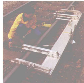
钢轨对正架梁
