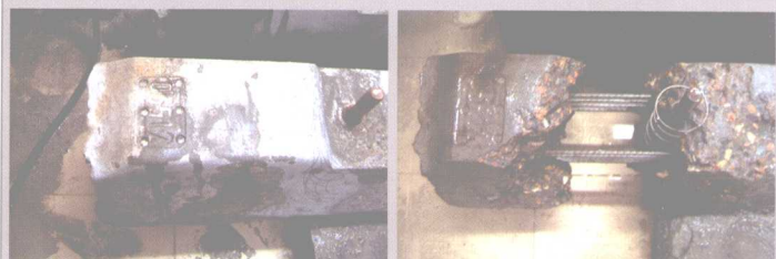
高效切割C60混凝土
