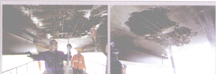
混凝土凿破
