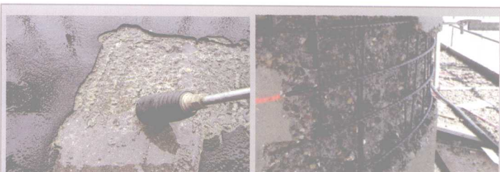
混凝土大面积凿毛
