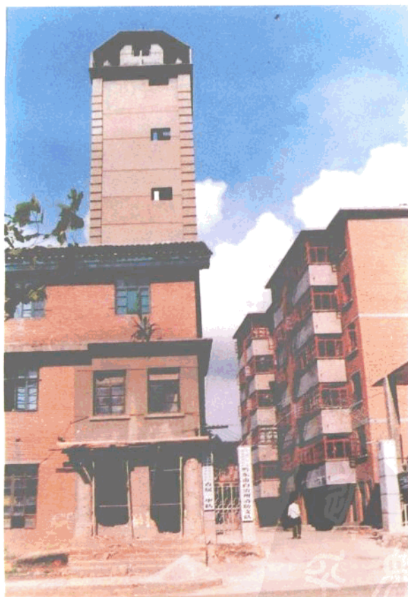
州公安消防支队瞭望台
