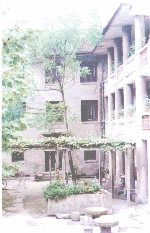
镇远专署公安处办公楼
