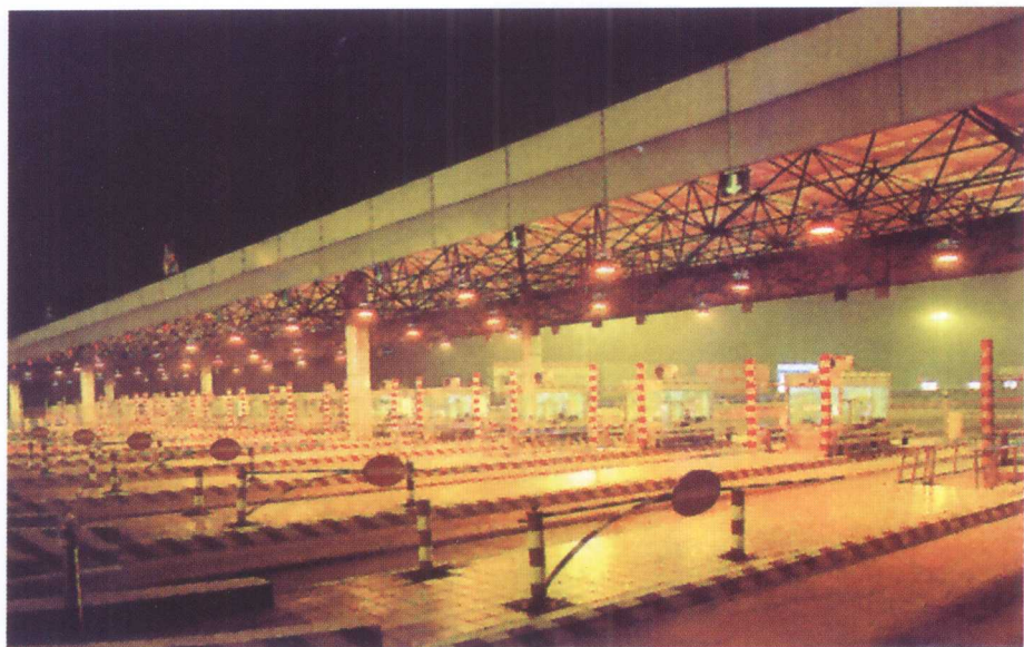
沪宁高速公路花桥收费站夜景
