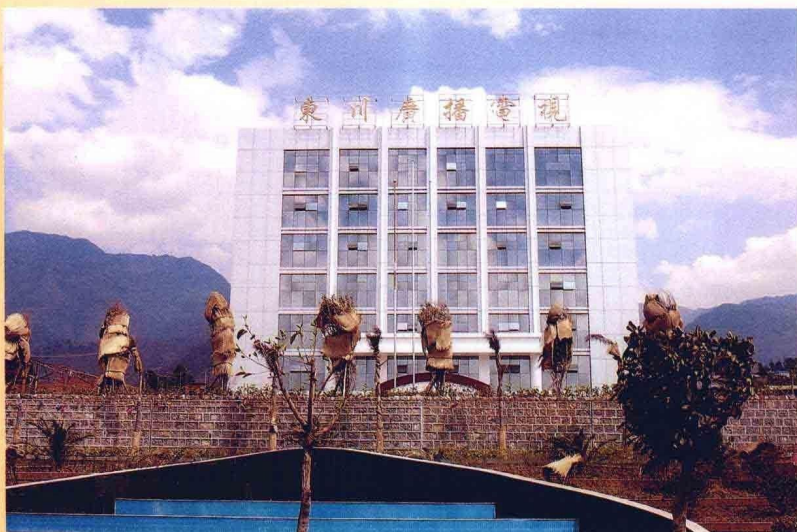
承建的东川广电大楼
