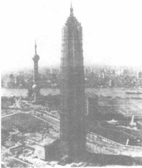
图 1-7 高层钢结构建筑
