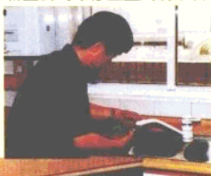
物业公司维修业主厨房设备
