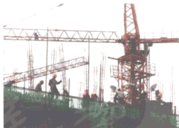
建筑施工噪声
