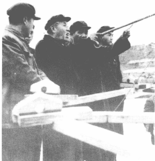
1960 年董必武视察丹江口水电站工地。
