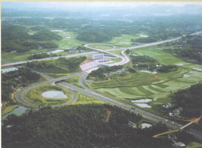
长益高速公路与长沙绕城高速公路互通立交
