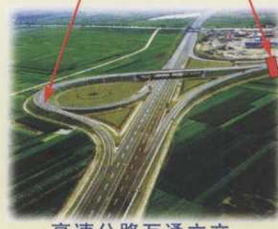
高速公路互通立交出入口实况照片
