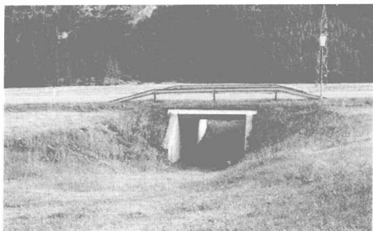
图5 奥地利某动物穿越地下通道
