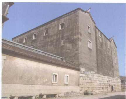
图 2-1-18 漳浦县湖西乡赵家堡完壁楼
