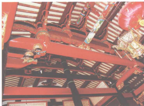
图 2-2-3 泉州市涂门街吴厝埕吴氏大宗祠寝殿心间架内三通五瓜梁架
