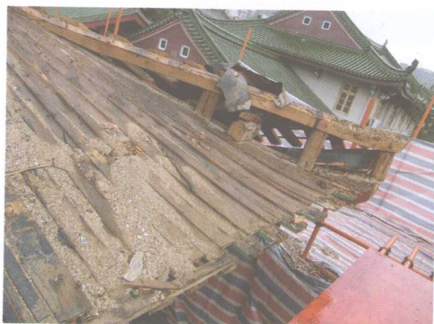
图 2-3-11 厦门南普陀寺天王殿下檐东南角 翼角暗厝
