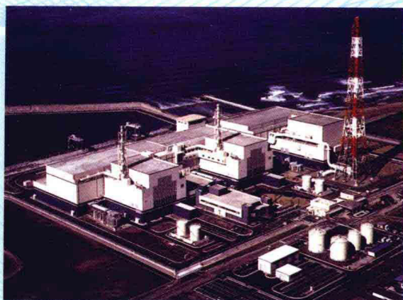
日本柏崎沸水堆发电厂
