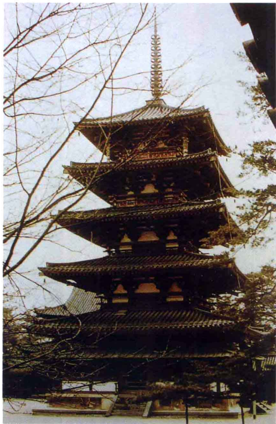
图2-6 日本奈良法隆寺五重塔
