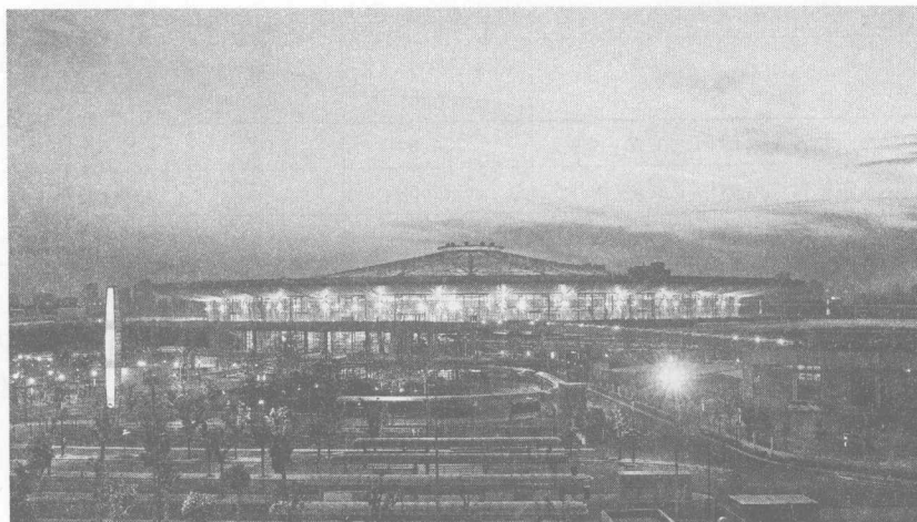
图1 主站屋夜景照片
