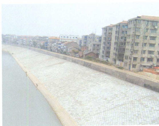
新江口城市防洪墙
