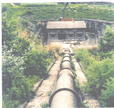
牌坊口电灌站
