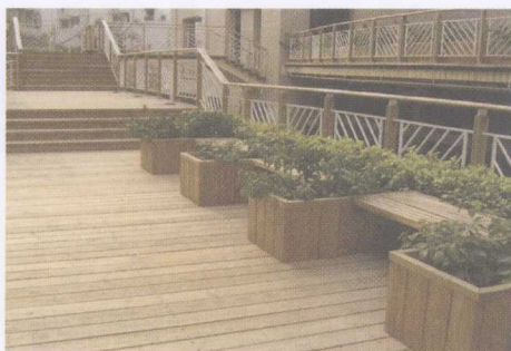
图 2-2 防腐木栈桥
