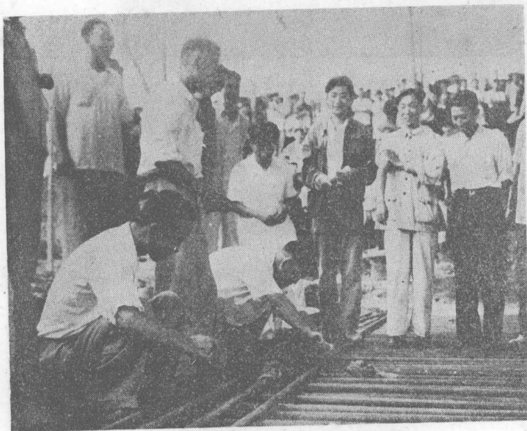
中共湖北省委第一書記王任重同志和中共武漢鋼鐵公司委員會書記、武漢鋼鐵公司總經理李一清同志在一號高爐的鋼筋混凝土基礎上結扎第一根鋼筋。
