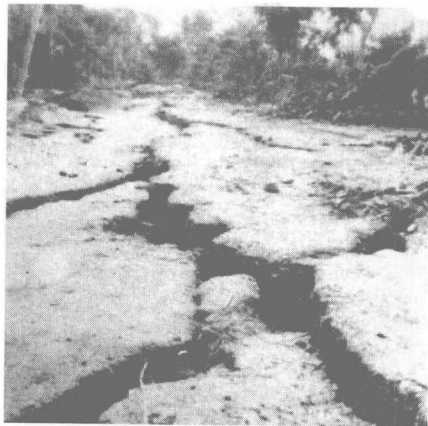
图 1-4 唐山大地震裂开的地面
