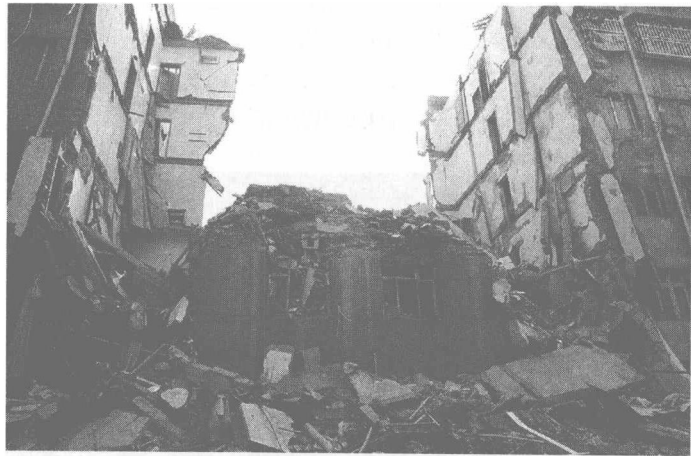
图 1-8 汶川大地震后毁坏的建筑群
