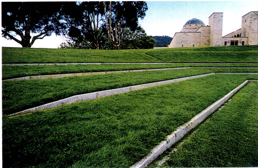
图 2-18 覆草斜坡加混凝土固坡。
