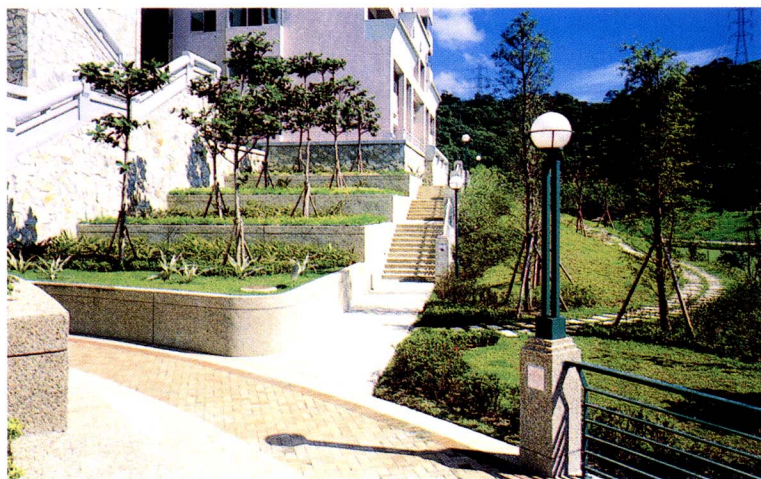
图 2-14 砌块贴面挡土墙(单位:mm)
