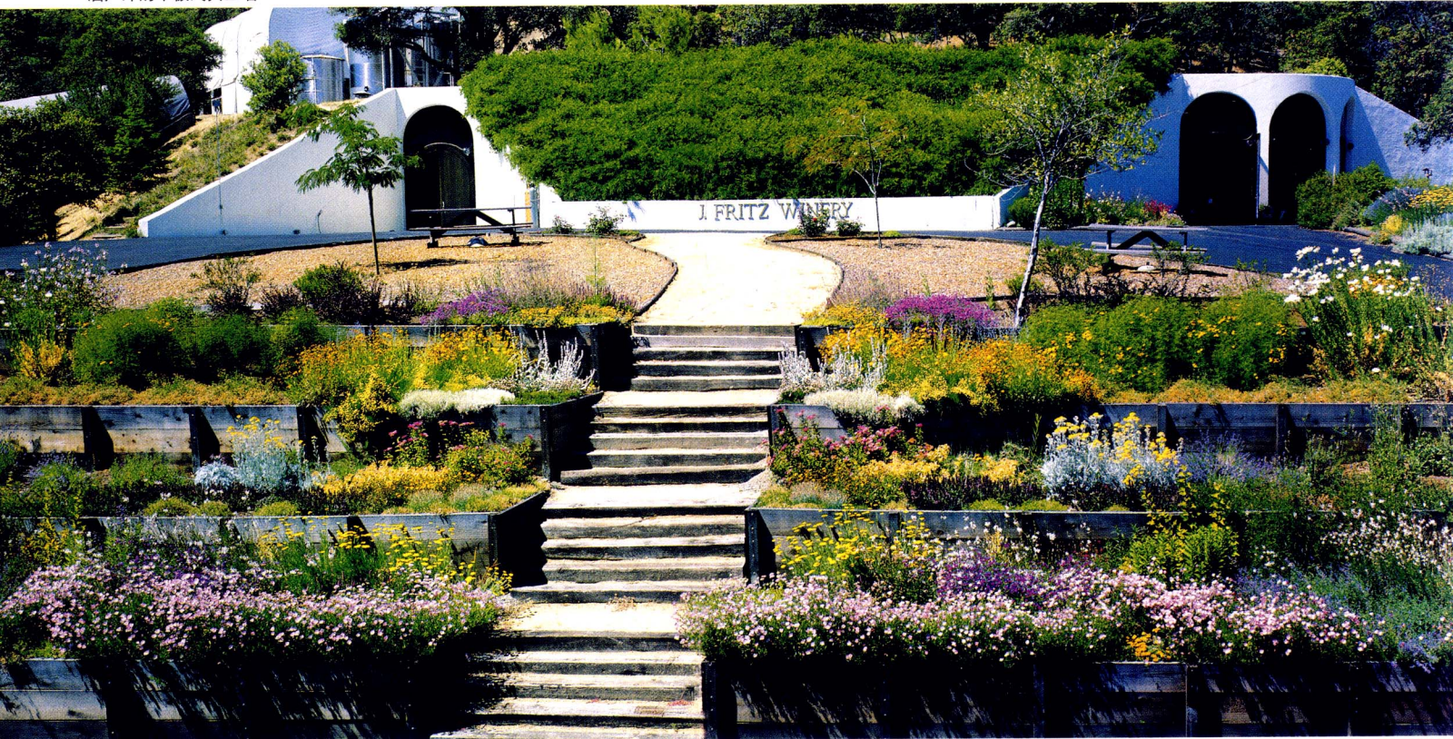
图 2-12 美国 J. Fritz 酒厂外的木板式挡土墙
