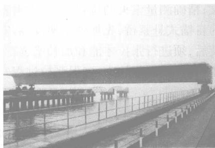
图8 预制箱梁移至出海码头
