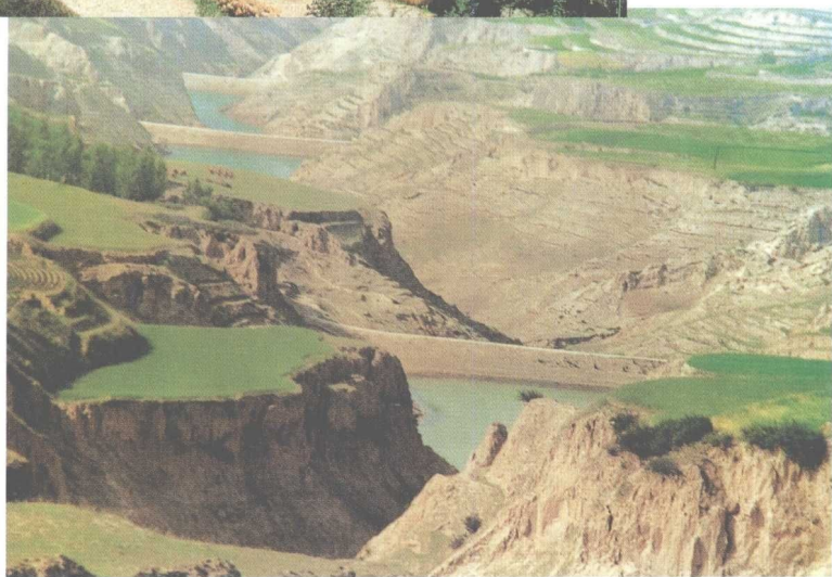
沟道内层层设防、节节拦蓄
