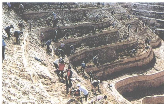
实施坡面工程措施，改变微地貌，减少水土流失
