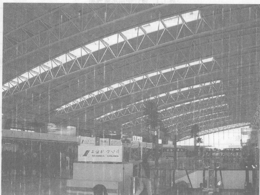
图 1.4 轻型钢结构
