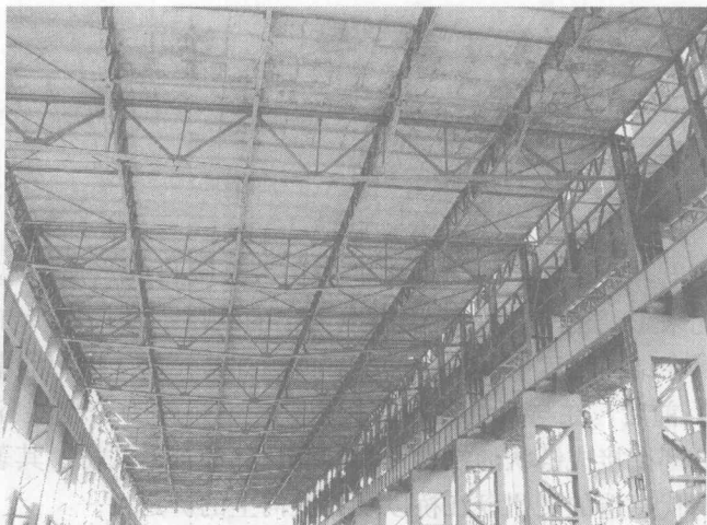
图 1.1 单层厂房结构
