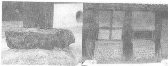
图3 韩国传统建筑中的柱石和柱子
