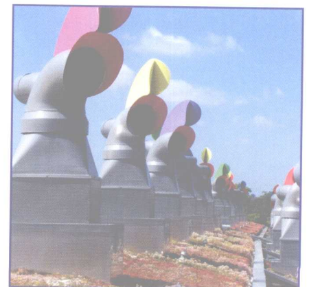
下图 BedZED项目的通风帽——最具识别性的零能耗产品之一。
