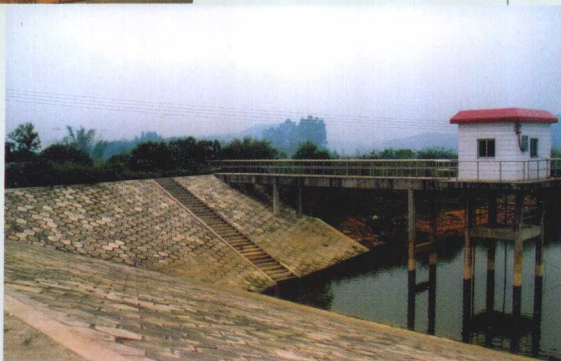
枕头湾水库一角
