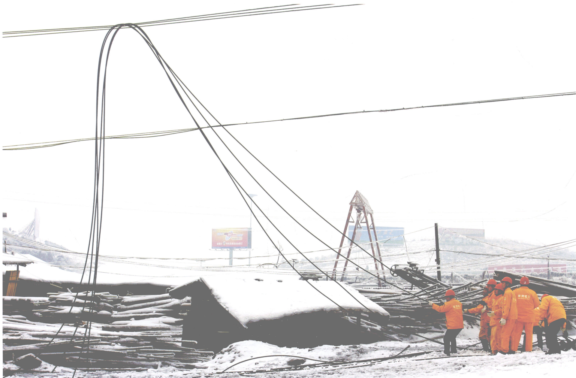
► 2008年2月2日，郴州。电力抢修工人将吊在空中的电缆一根根地拉下来。| 袁艺·摄 |
