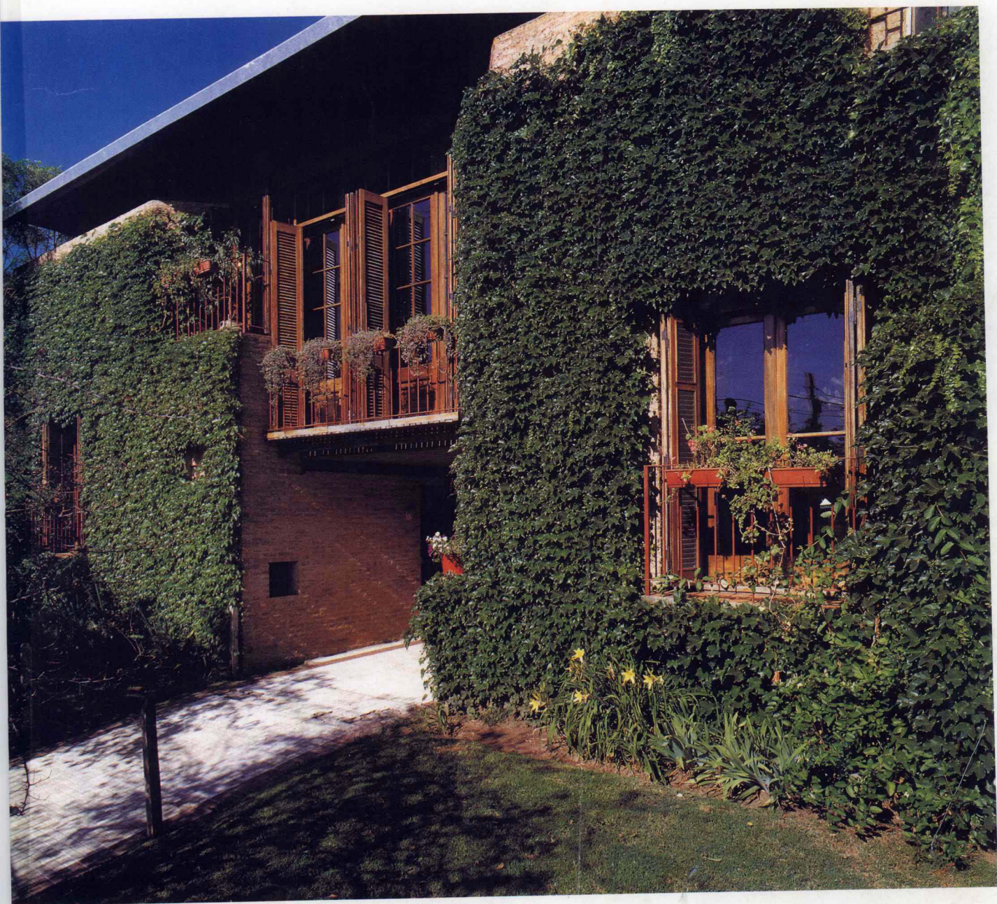
别墅正立面入口局部
