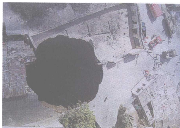
图4 漏斗状塌陷(二)
