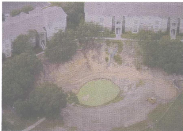
图3 漏斗状塌陷(一)
