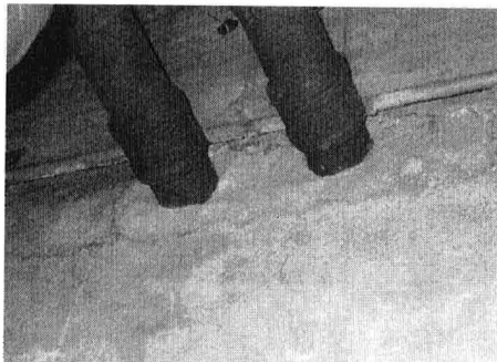
照片 29.6 怎样处理贯通防火分区示例
