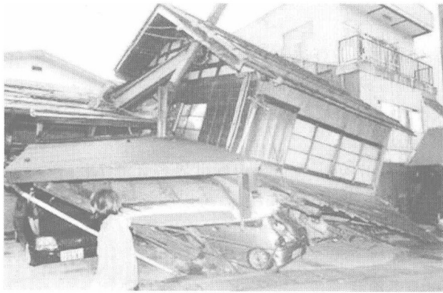
图 1-3 地震后建筑物破坏情况
