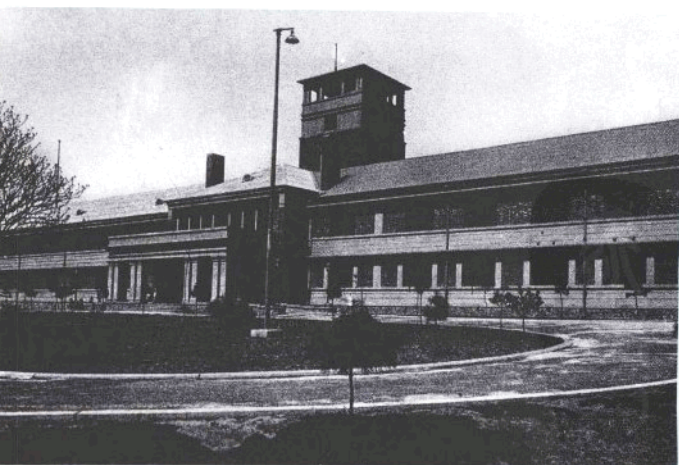
12.开滦矿区唐山办公大楼(1937年建成)
