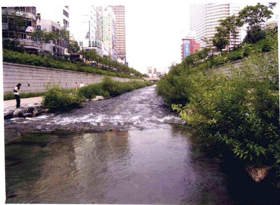
韩国清溪川两岸的人工生态植物堤岸
