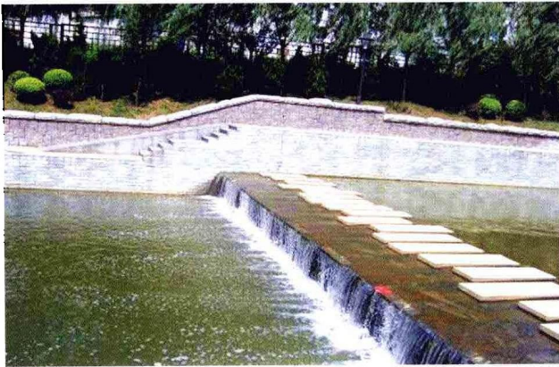
大村河中无法通过的过河通道
