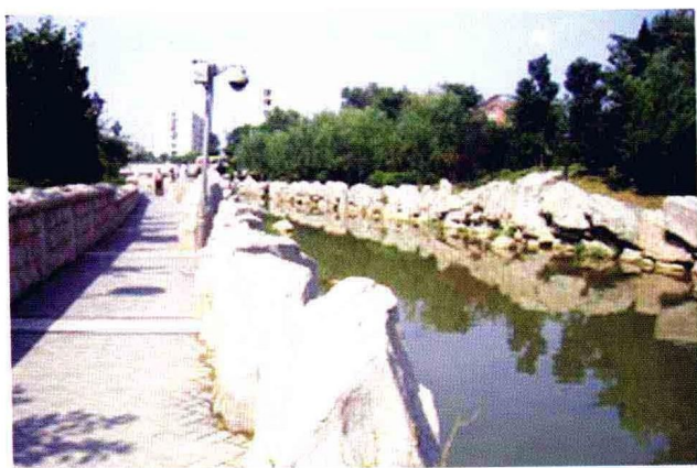
大村河的石块护坡
