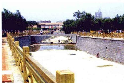
海泊河河道的硬化水泥河底
