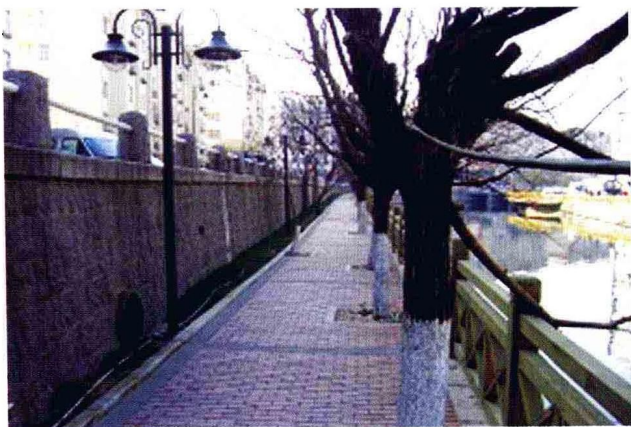
海泊河垂直的护坡墙体
