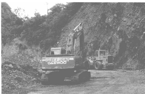
图1-6 挖掘机、运土车发出的轰鸣声，唤醒了沉睡的深山
