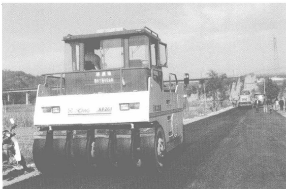
图1-5 采取现代施工技术,正在铺筑沥青路面,农民朋友多年的期盼即将成为现实
