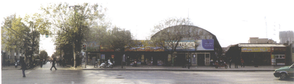
文景路枣园市场东立面现状
