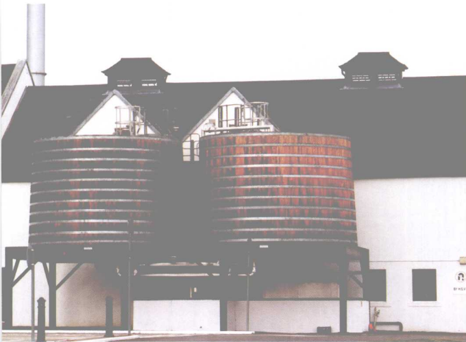
▲安放在户外的设备，可以把酿好的酒精冷却液化（达尔维尼酒厂）。
