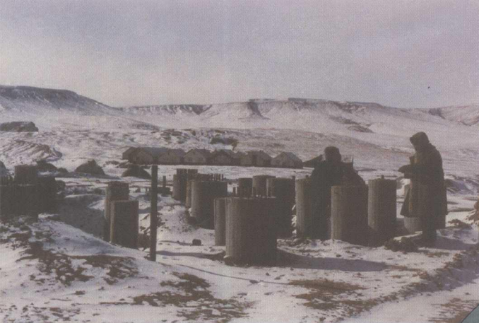
1982年桩基试验场
