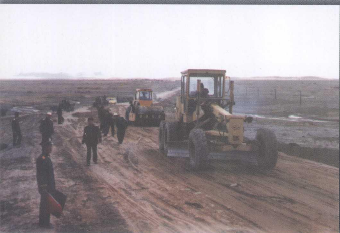
◀ 整治工程施工现场
