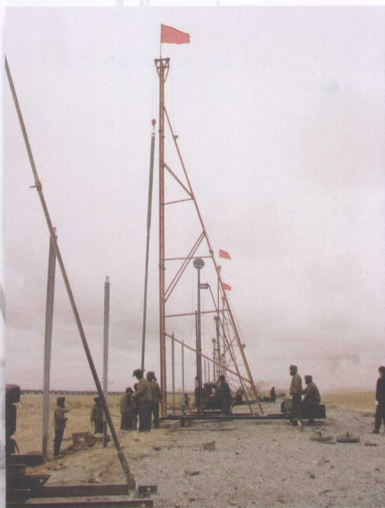
2001-2002年热棒安装施工现场
