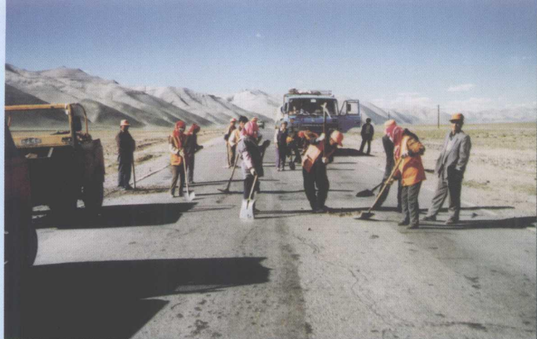
▶ 青藏公路处治道路病害
