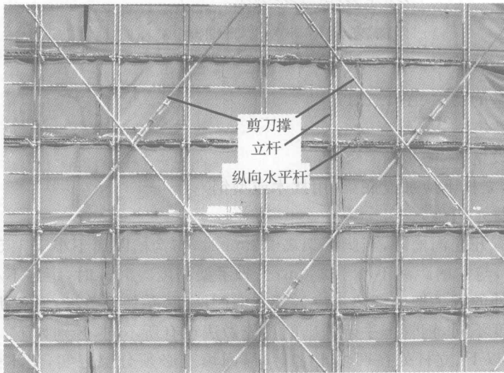
图 1.2.2 扣件式钢管脚手架
