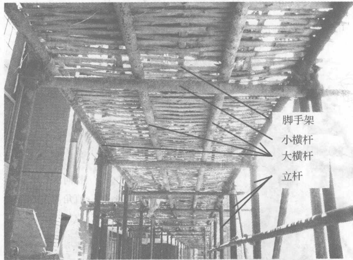
图 1.2.3 脚手架构造图
