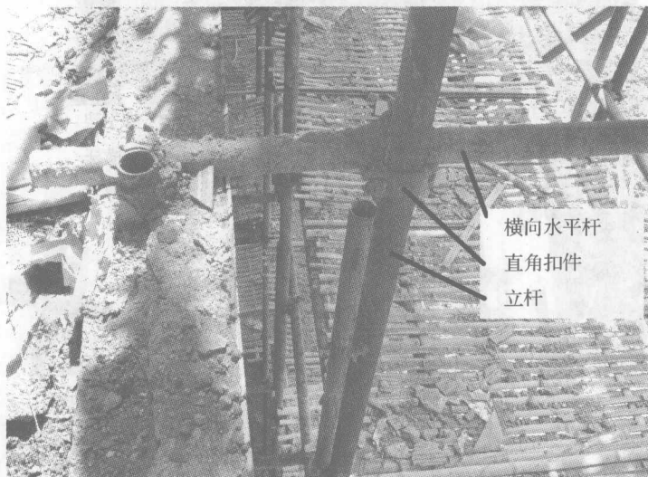
图 1.2.6 连墙杆实照
