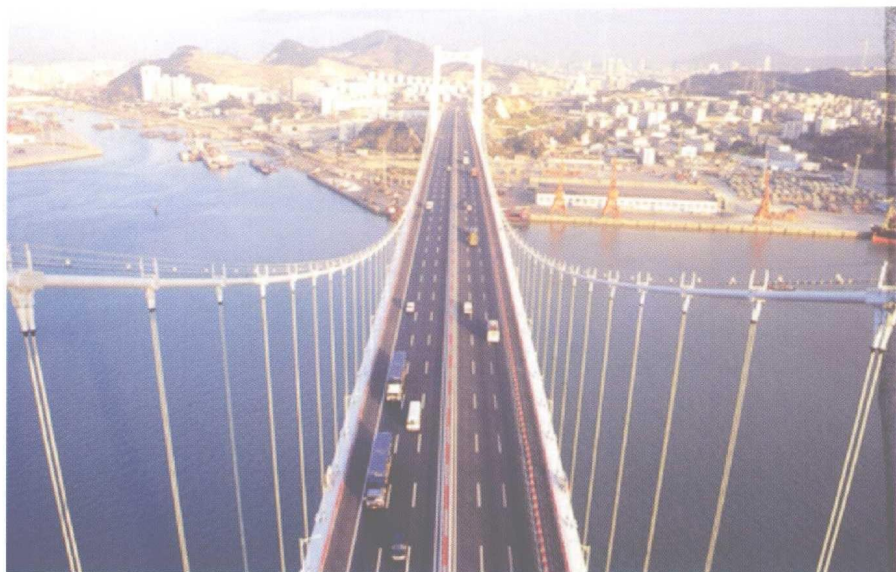
厦门海沧大桥
