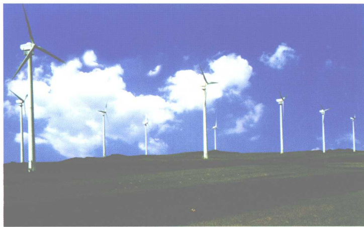
张家口风力发电站
