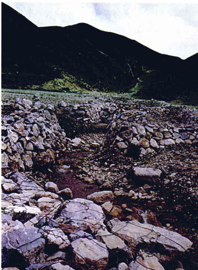
玉树县孟宗沟小流域 治理现场，这里已被列为 水利部长江水土保持小流 域综合治理的试点。这是 用铅丝笼石坝的工程设施。 (徐 冶 摄)
